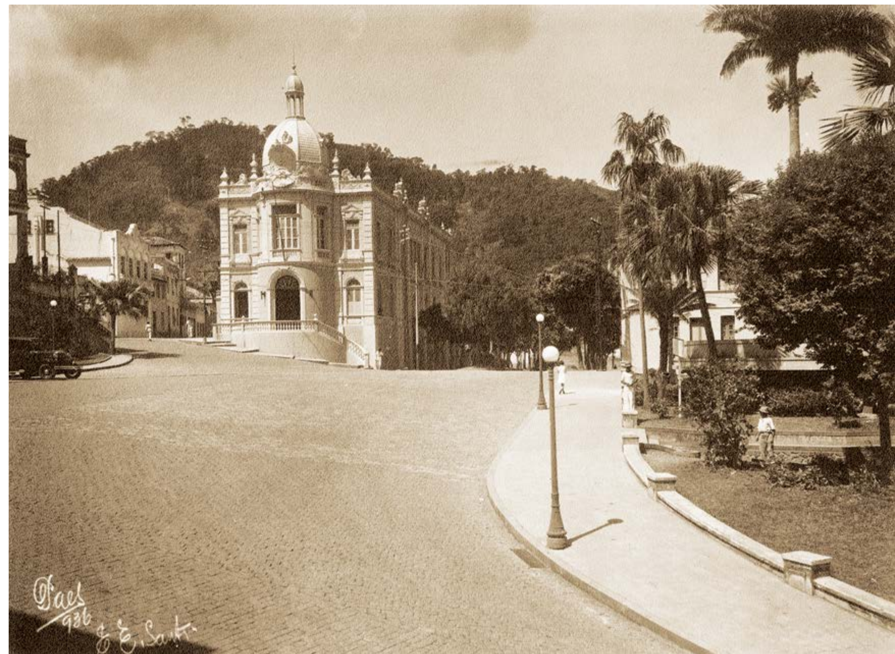
O então presidente do Estado, Jerônimo Monteiro, construiu uma suntuosa nova sede para o Congresso Legislativo, que também colocava-se como um dos ícones da modernização urbanística de Vitória
